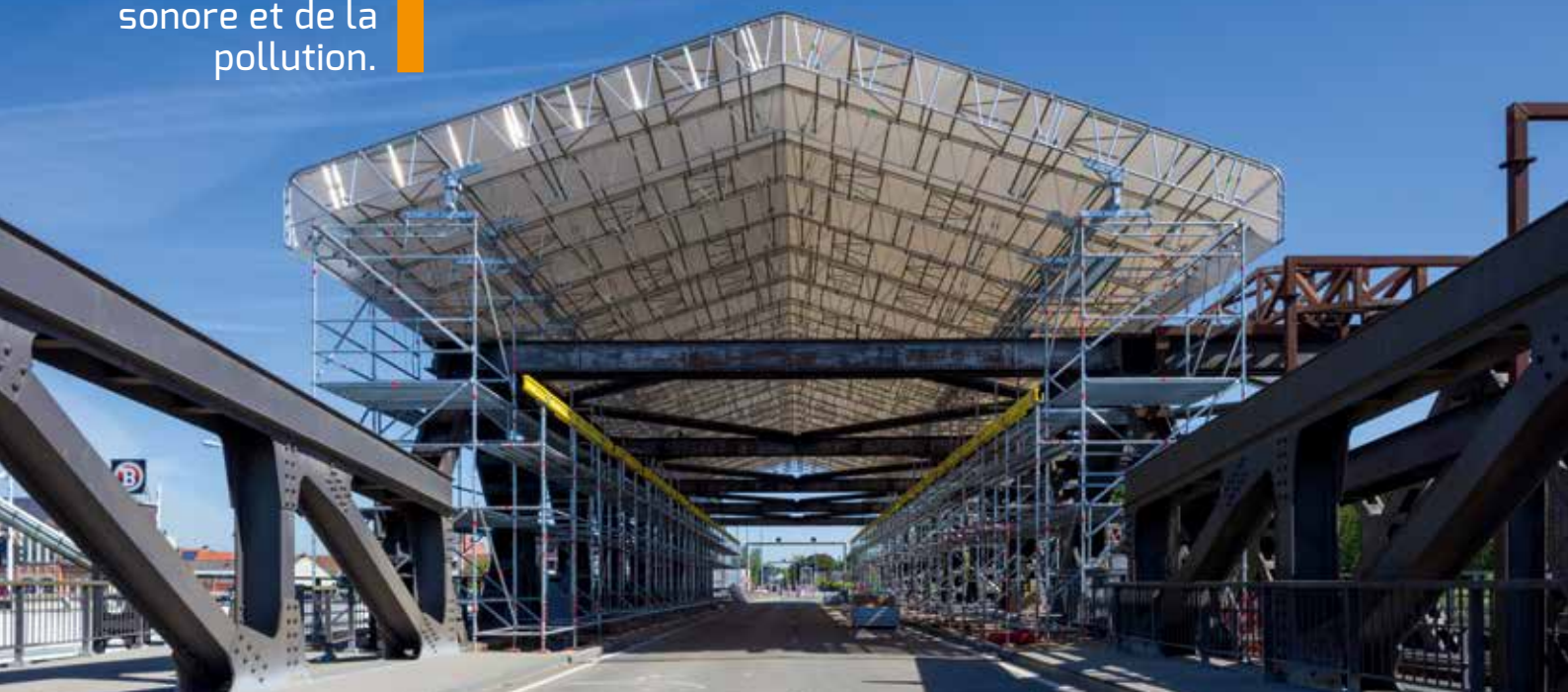
La toiture roulante aménagée au-dessus du pont de Temse a permis sa rénovation rapide.
