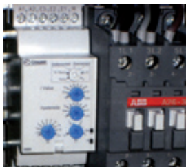
Limiteur électronique de charge
