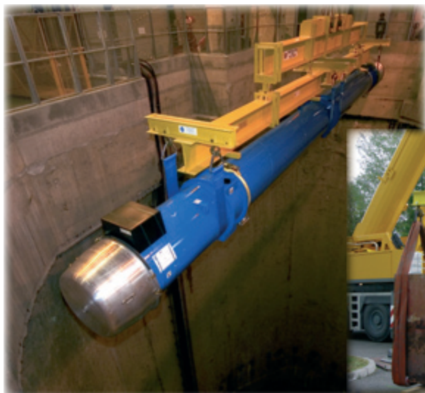
Descente du 1 er cryodipole (35.4t) à 100 mètres profondeur. (CERN, Genève 2005)
